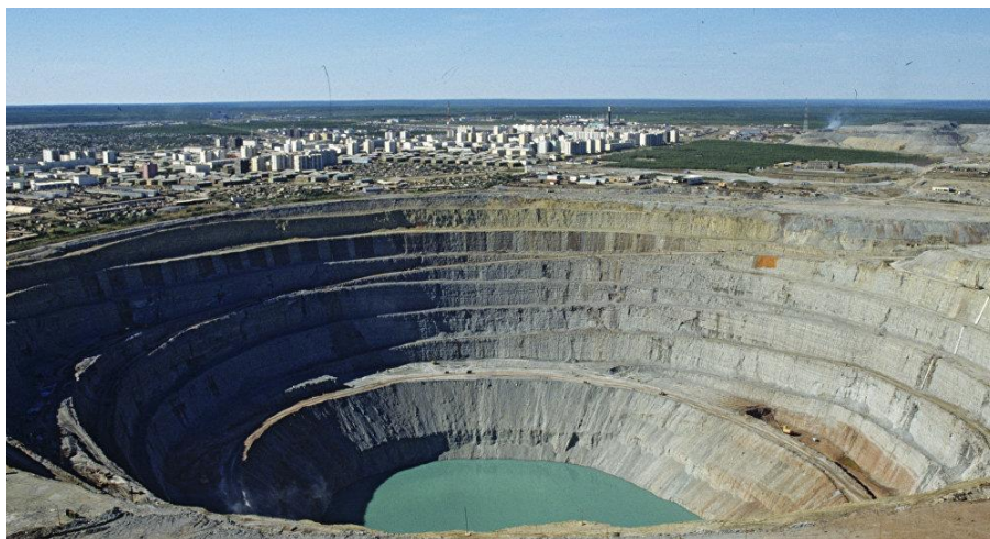
Рисунок 1. – Затопленный карьер кимберлитовой трубки «Мир» накануне прорыва воды в подземный рудник (конец июля – начало августа 2017 года).
