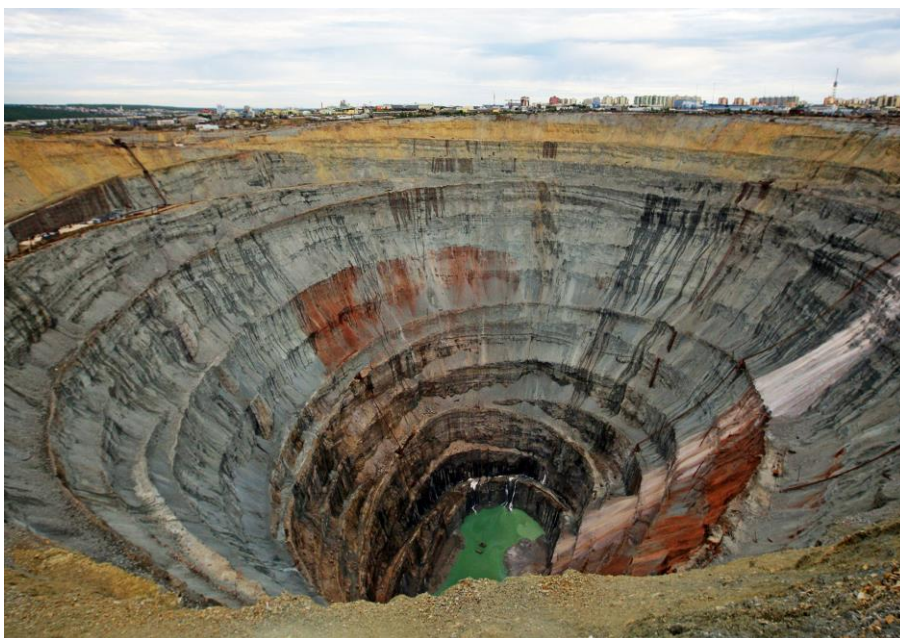
Рисунок 2. –Карьер рудника «Мир» после прорыва воды в подземные выработки. Хорошо видны полностью заплывшие борта и уступы карьера.
