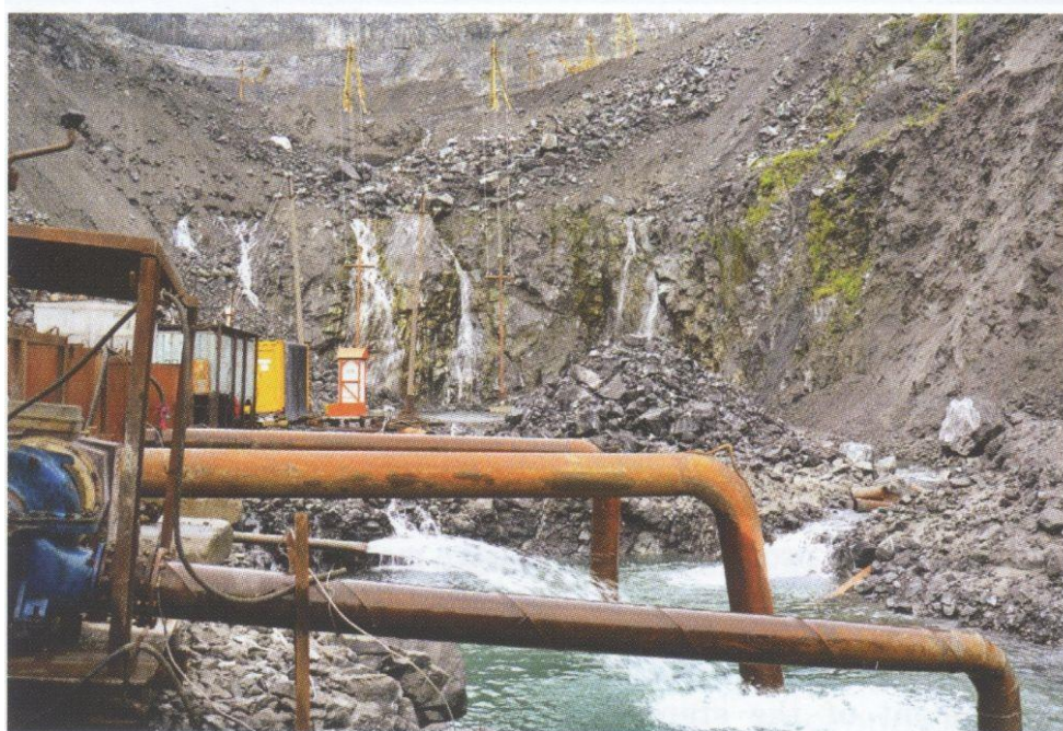
Рисунок 12. Борьба с карьерными водопритоками с помощью передвижных насосных станций на руднике «Железный».
