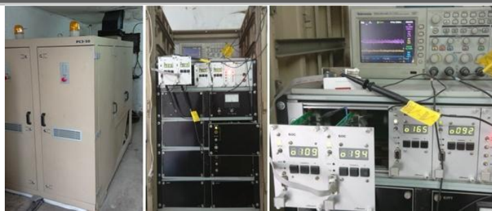
Рисунок 2. Блоки обработки сигналов, расположенные в стойке управления сепаратором
